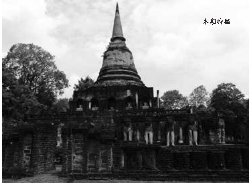
环象寺，成排大象撑起整座佛塔。
